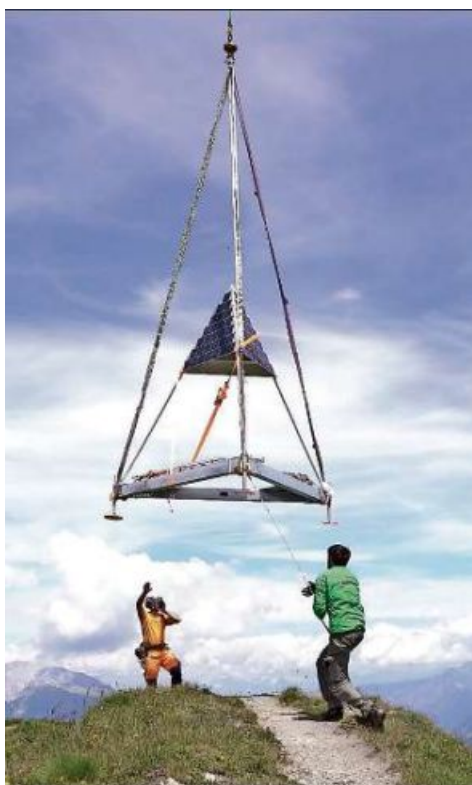
Aufwendiger Transport der Wetterstation-Installation auf das Schläechtlü. Pressebild
