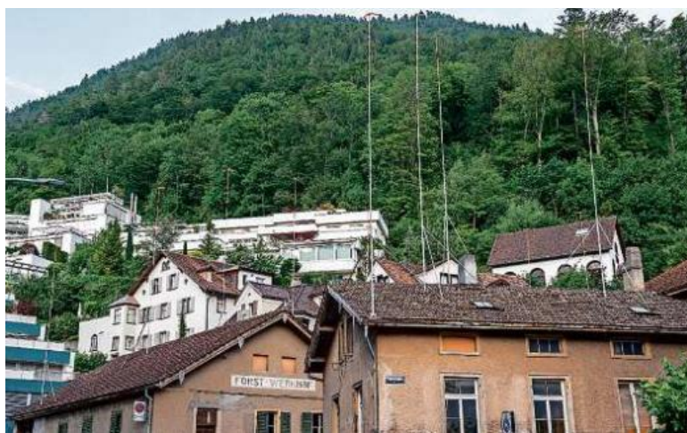
Die Tage sind gezählt: Zumindest dem Abbruch des Alten Forstwerkhofs steht nun nichts mehr im Wege. (FOTO YANIK BÜRKL)
